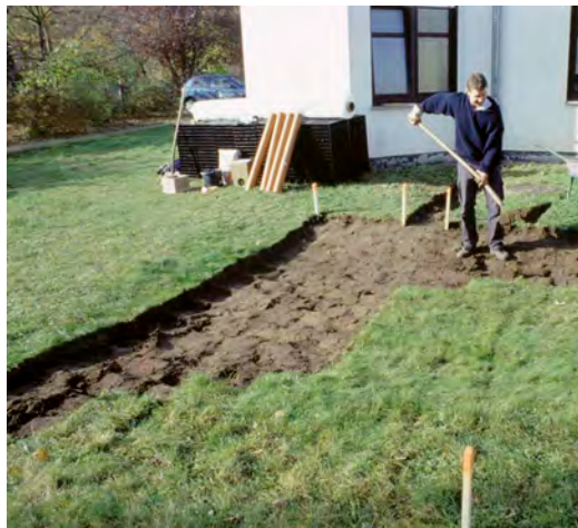
Abb. links: Abstecken der Baugrube.
