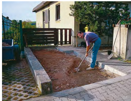
Abb. links: Randsteine setzen.
