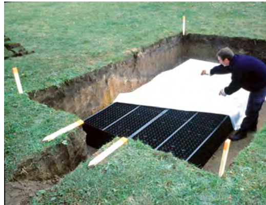
Abb. links: Einsetzen der Kunststoffelemente.
